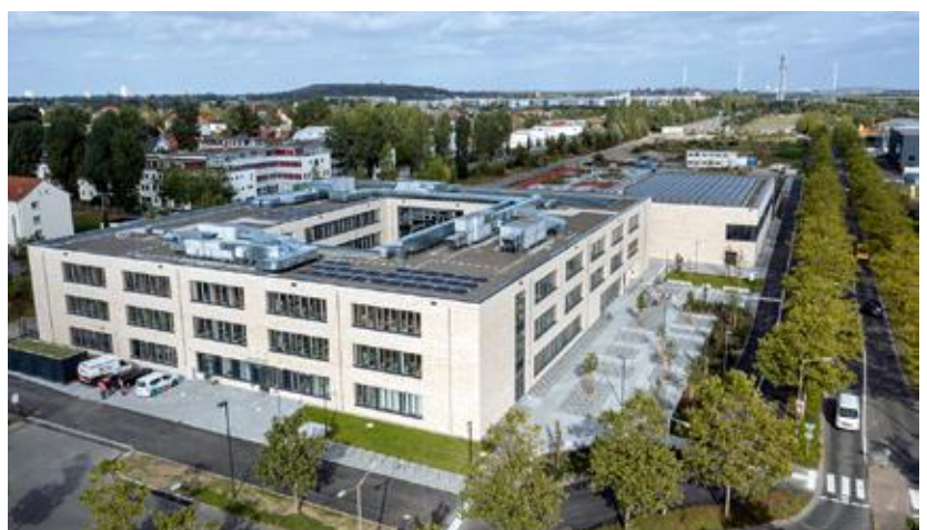
In der neu erbauten Oberschule Wiederitzsch an der Messe-Allee 21 lernen derzeit mehr als 300 Kinder.
